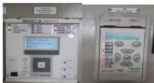
Gambar 5. Indikasi Relay OCR LV Trafo 3 dan OCR Penyulang Kosmetik
