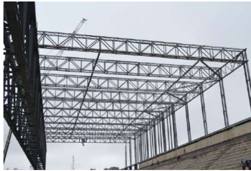
Gambar 4. Rangka Space Frame (sumber : stadiumdb.com)
