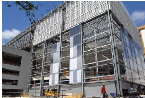
Gambar 2. Fasad Plat Besi Non Struktural (sumber : stadiumdb.com)
