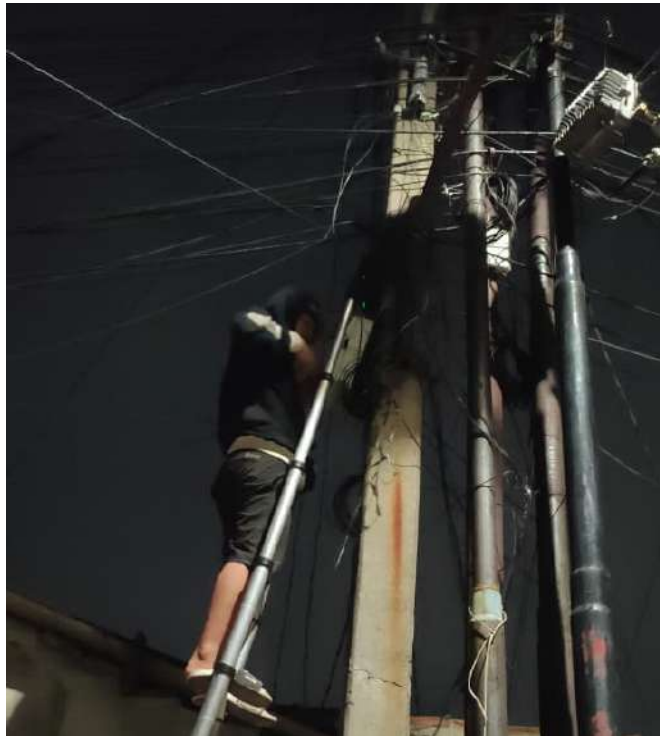
Gambar 4. Penarikan Kabel Jaringan Fiber Optik Dari ODC ke ODP Baru.
