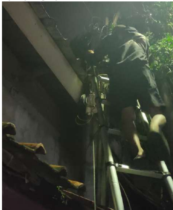
Gambar 5. Penempatan dan Pemasangan ODP Baru.
