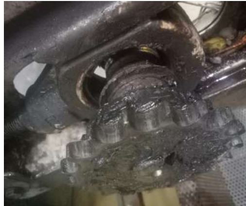
Gambar 7. Penggantian bearing yang pecah
