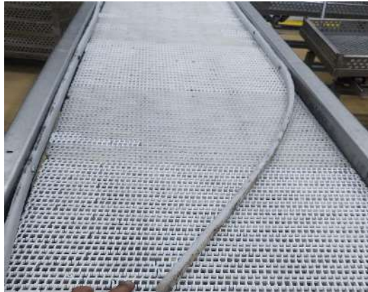
Gambar 2. Perbaiki penyangga modular
