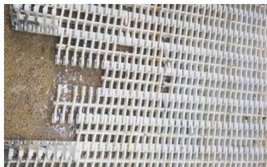
Gambar 6. Proses perbaikan penyambungan modular
