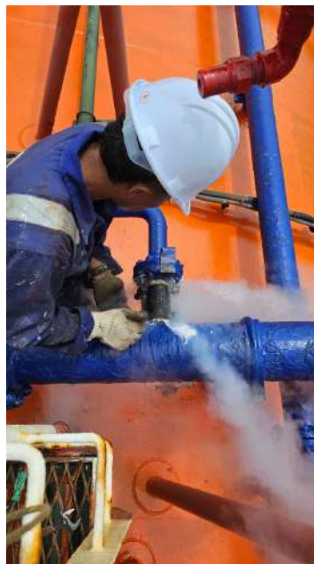
Gambar 2. Proses Pengecekan dan Penanganan Kebocoran oleh Awak Kapal Sumber: Dokumentasi MT. Gas Estella (2025)
