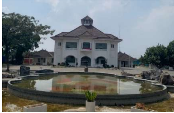
Gambar 4. Museum Bekasi Gedung Juang Tampak Luar
