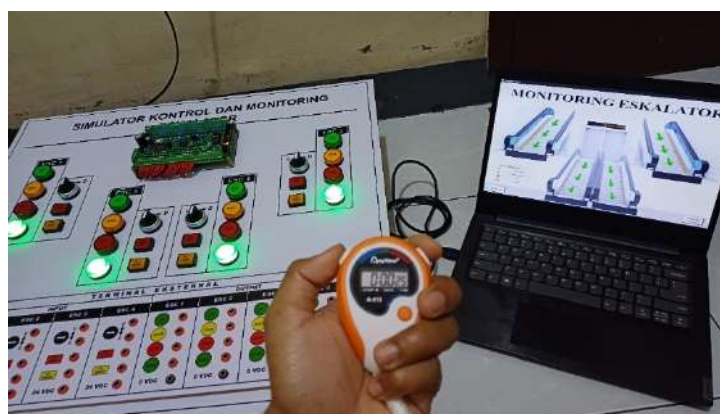
Gambar 5. Pengukuran Respon Waktu SCADA Menggunakan Stopwatch
